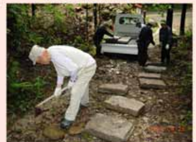
【石畳の設置作業】
